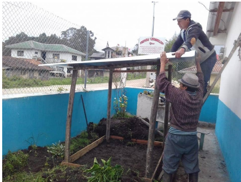
Figura 1.4. -Construcción de la compostera. Fotografía de Moya B. (San Vicente de Gulazh. 2018).
