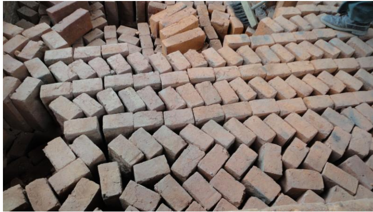
Fotografía 29: Disposición de ladrillos. 24 de Mayo-Sinincay
