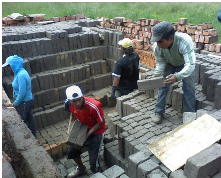
Fotografía 30: Disposición de ladrillos. Chambo-Riobamba
