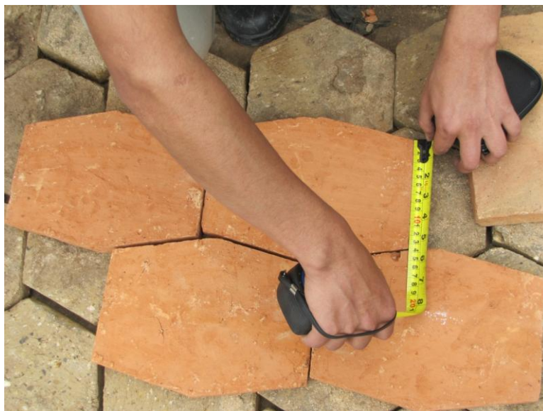
Fotografía 36: Medición de ladrillo de piso
