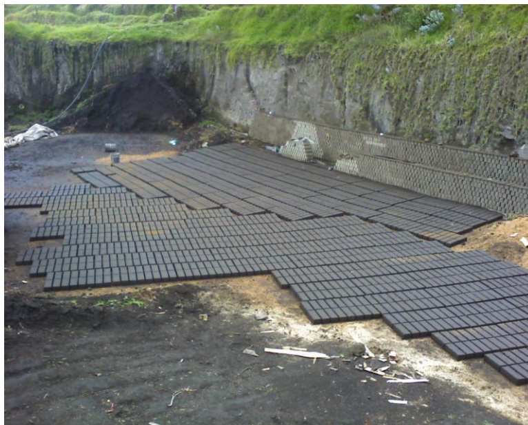
Fotografía 10: Disposición de ladrillo. Chambo-Riobamba.
