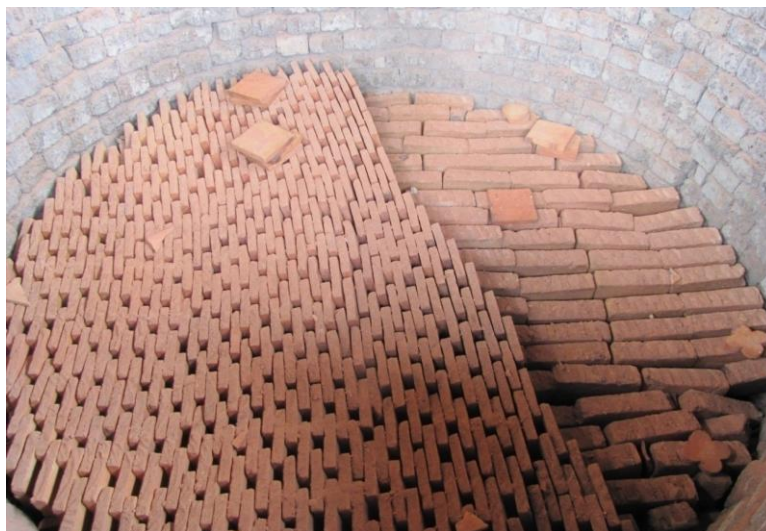
Fotografía 6: Colocación de ladrillo Panelón y obra en Horno circular
