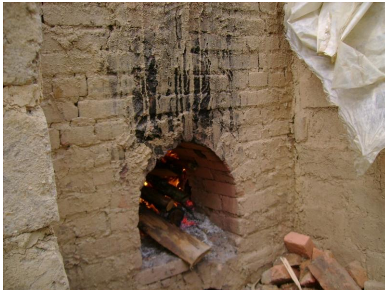
Fotografía 14: Caldera de horno
